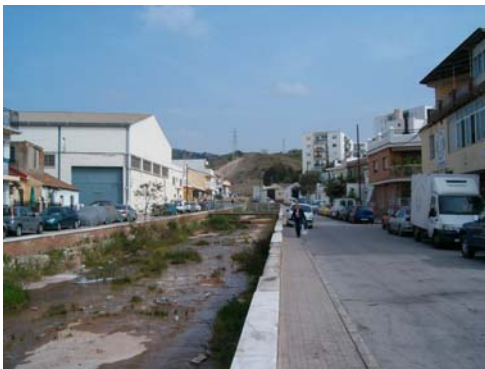
Polígono con viario y accesos insuficiente
